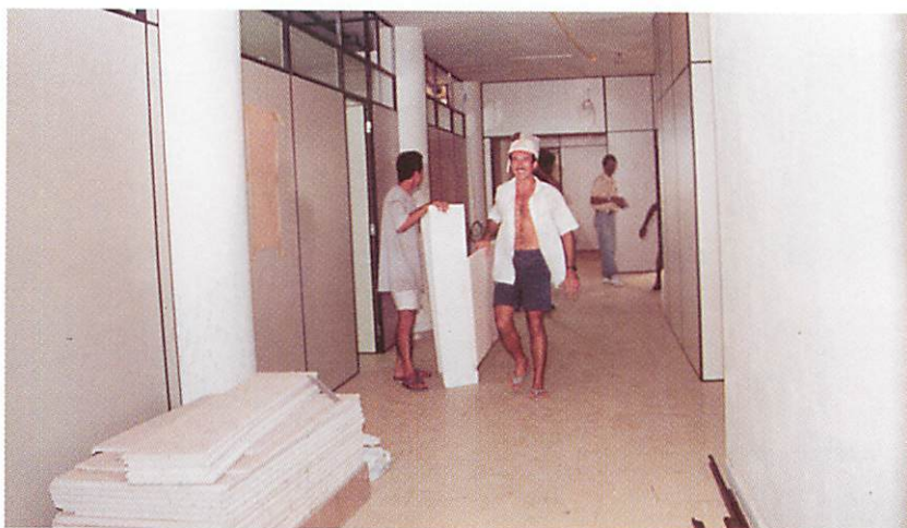
Reforma do 4º pavimento do Edifício "Walter Franco", onde funcionarão o Centro de Apoio Operacional, os Núcleos de Apoio Operacional do Ministério Público, as Promotorias de Justiça de Defesa do Consumidor, Direitos do Cidadão e Patrimônio Público Social, Cultural e Natural, o Programa de Defesa Comunitária, as Salas de Audiência, o Mini-Auditório e a Biblioteca "Prof. Gonçalo Rollemberg Leite". Já em fase final.
