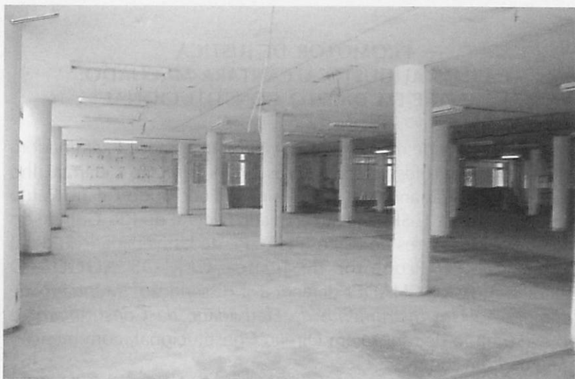
3º pavimento do edifício-sede da PGJ, em obras.
