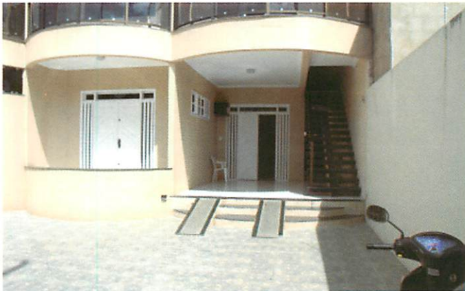
Foto 12 - Vistoria em Abrigo - Lagarto/SE
