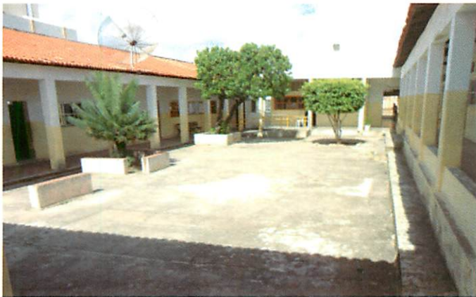
Foto 10 - Vistoria em Escola Municipal - Aracaju/SE
