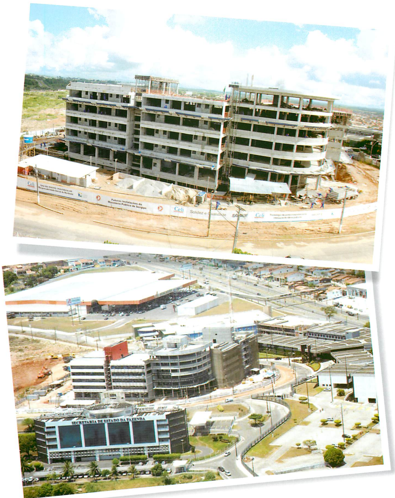
Fotos 26 e 27 - Obra Nova Sede MPSE
