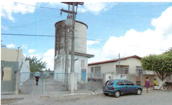
Foto 14 - Vistoria na Companhia de Abastecimento de Água - Simão Dias/SE
