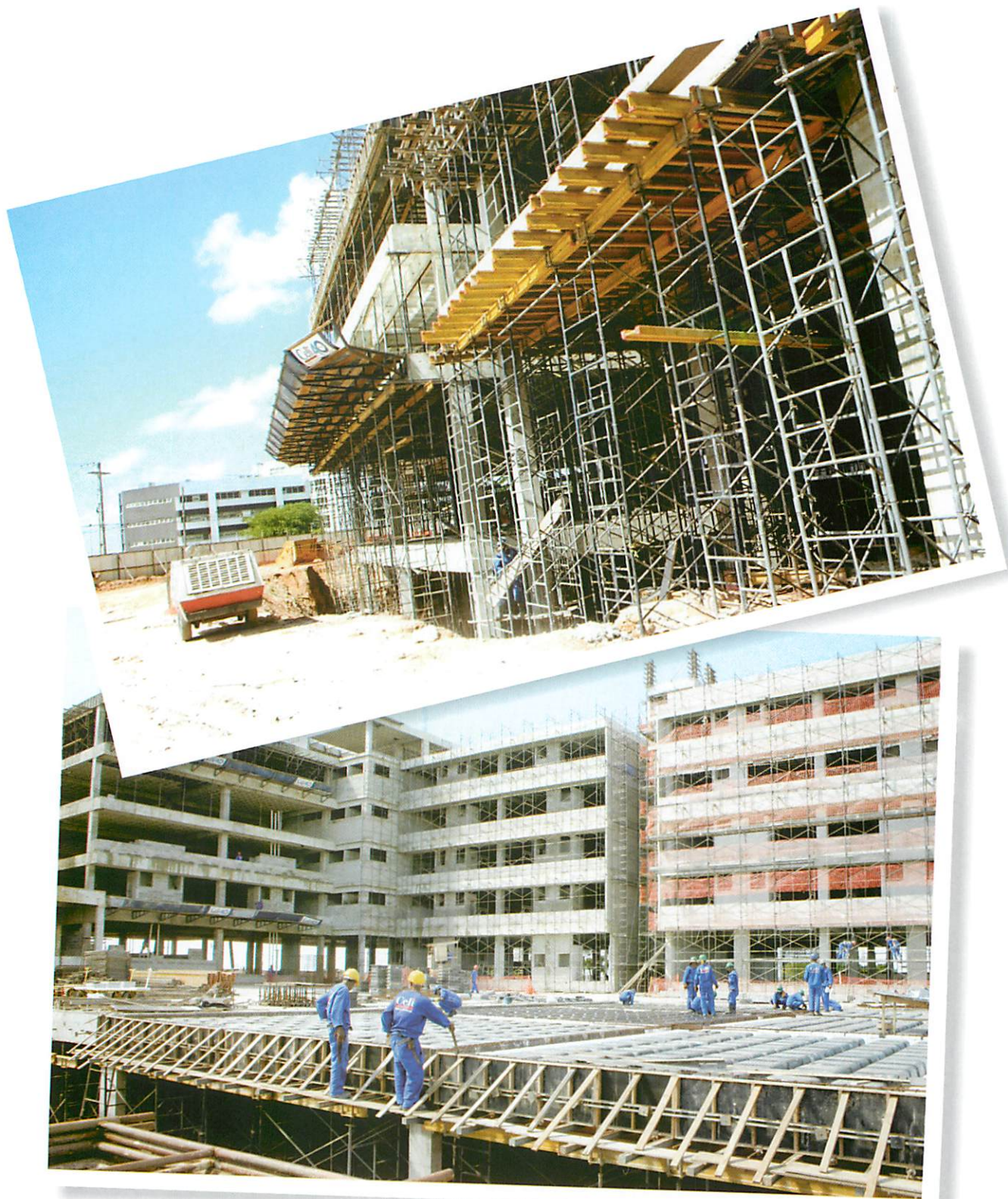
Fotos 24 e 25 - Obra Nova Sede MPSE
