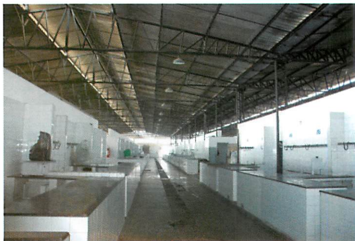
Foto 6 - Vistoria no Mercado Municipal - Lagarto/SE
