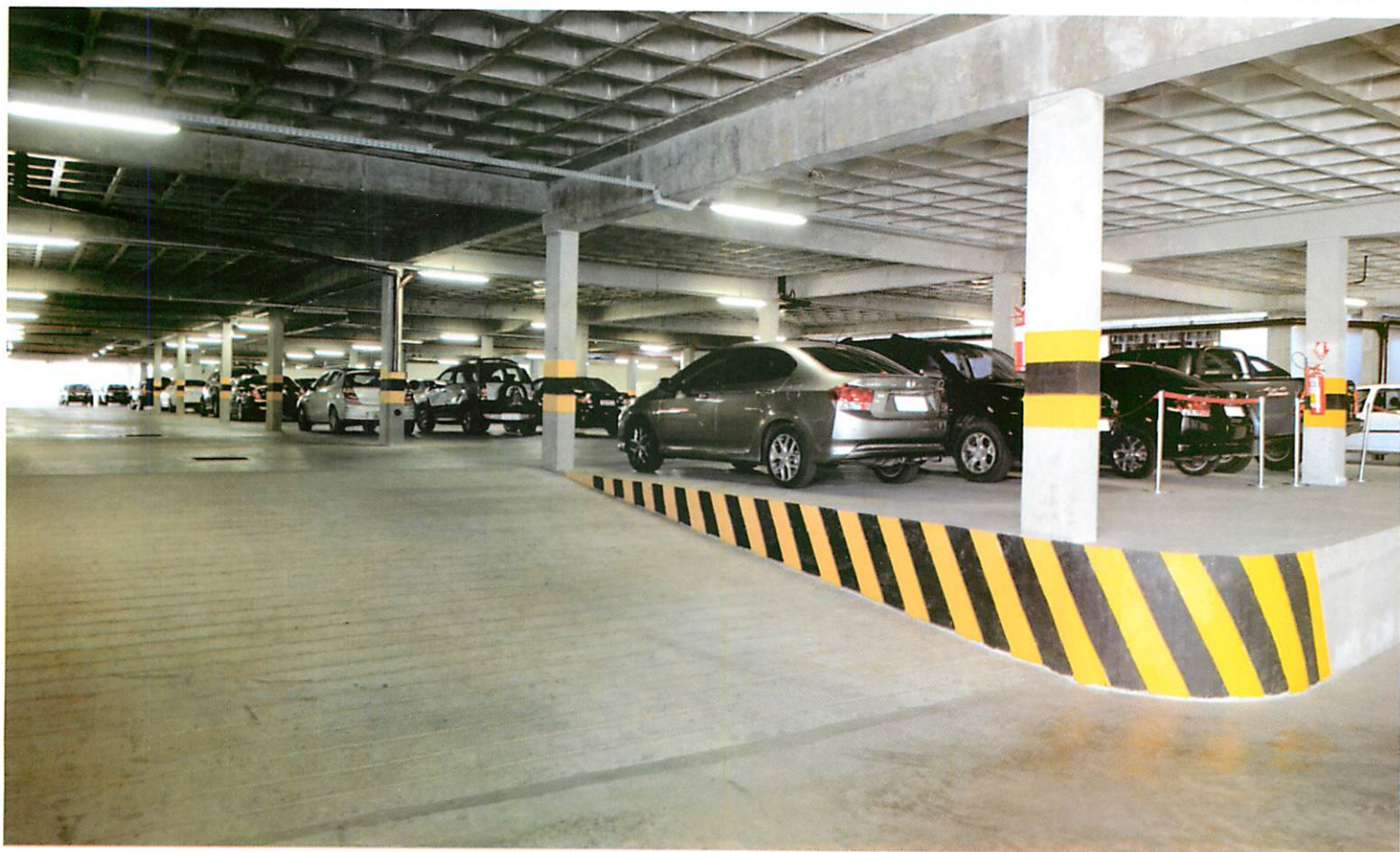
Foto 22 - Estacionamento Interno do Subsolo
