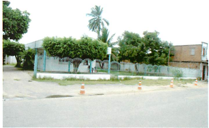
Foto 11 - Vistoria no 1º Batalhão da PMSE - São Cristóvão/SE
