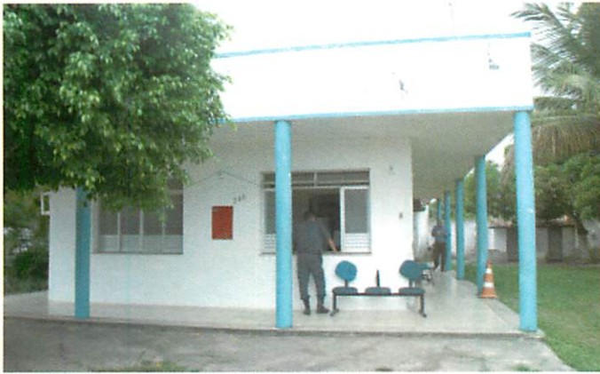
Foto 8 - Vistoria de Acessibilidade no 1º Batalhão da PMSE - São Cristóvão/SE
