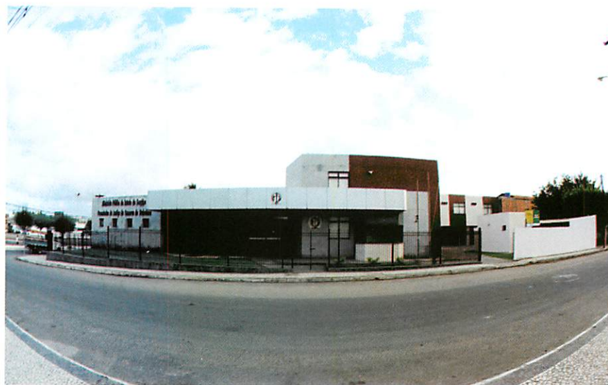
Foto 39 - Subsede de Itabaiana após a Reforma
