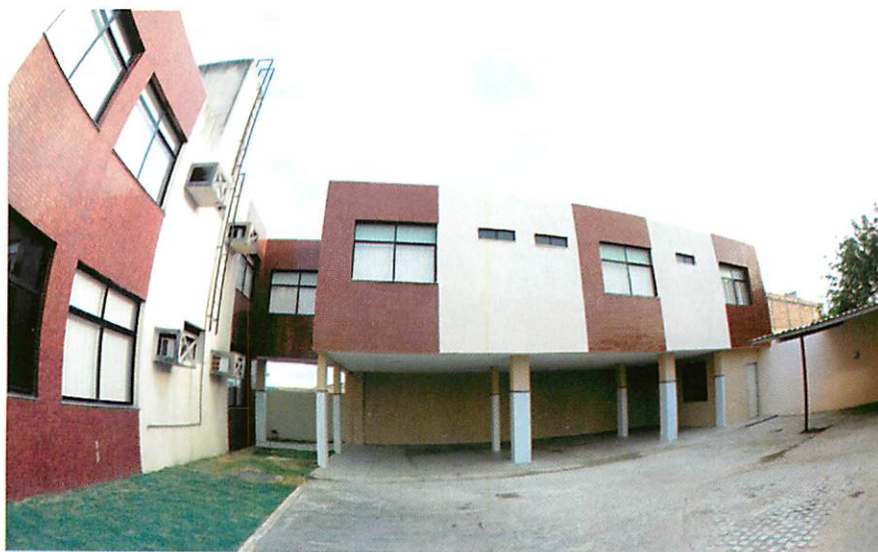
Foto 40 - Ampliação da Subsede de Itabaiana
