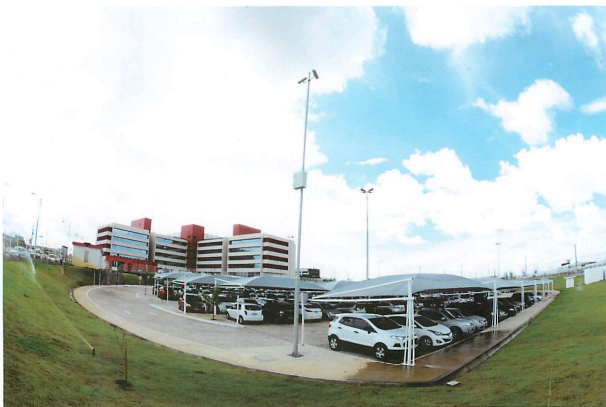
Foto 9 - Cobertura do Estacionamento para Servidores e Visitantes do MPSE
