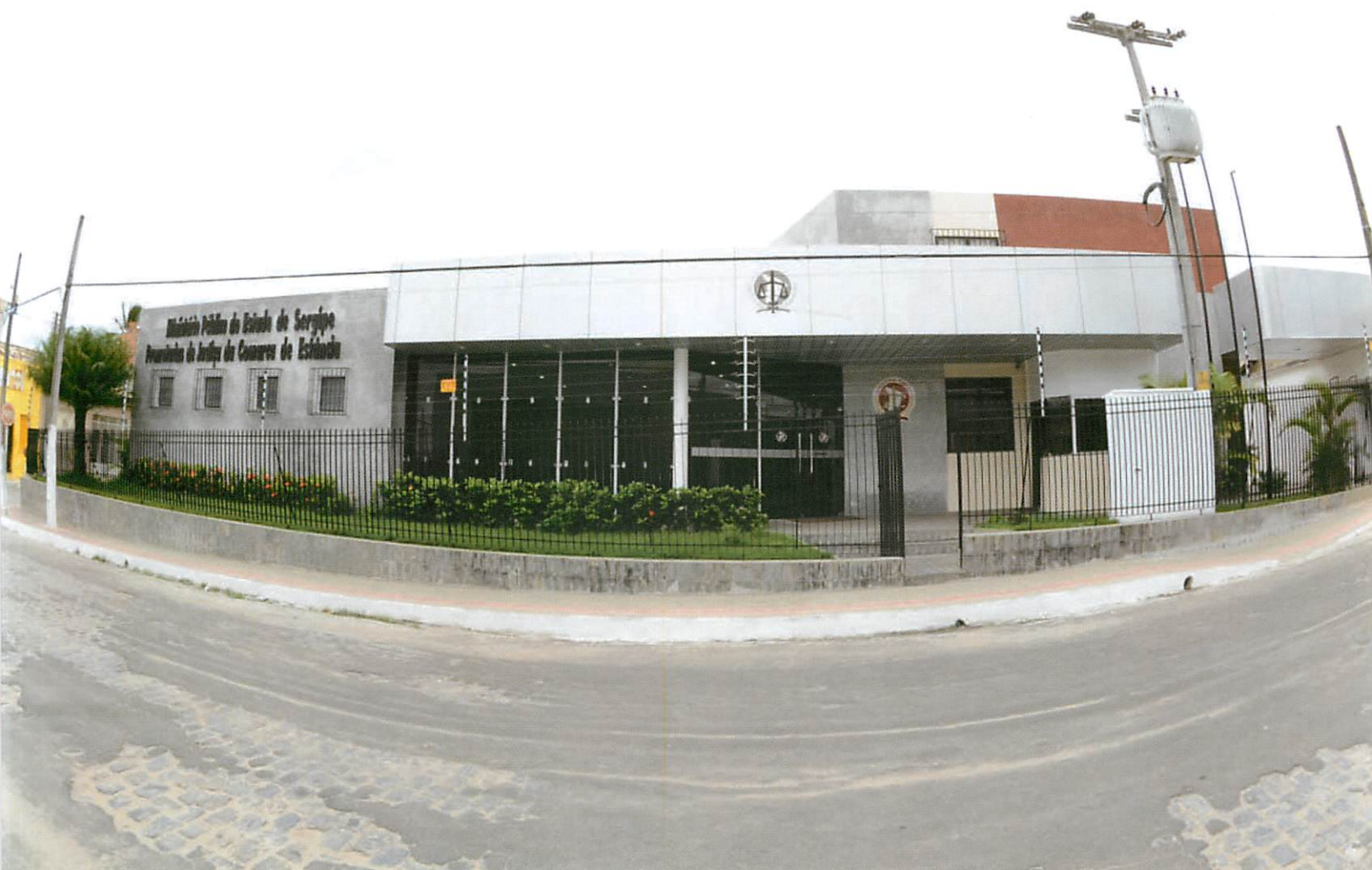
Foto 10 - Piso Tátil e Rebaixamento de Calçada na Subsede de Estância
