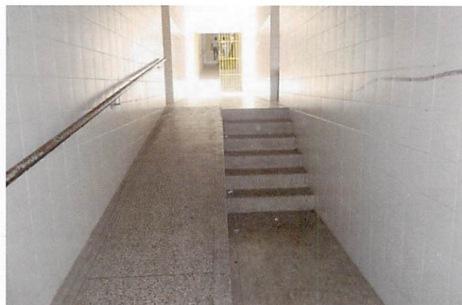
Foto 7 – Rampa de acesso às salas de aula da Escola Lourival Fontes - Aracaju
