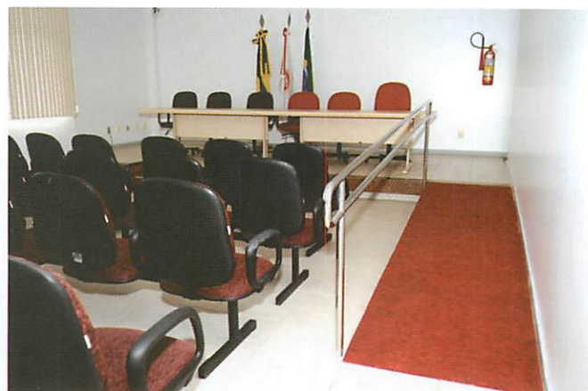
Foto 12 - Construção de Rampa de Acessibilidade em Miniauditório da Subsele de Estância
