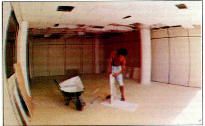
Operários concluem obras de reforma na PGJ.
